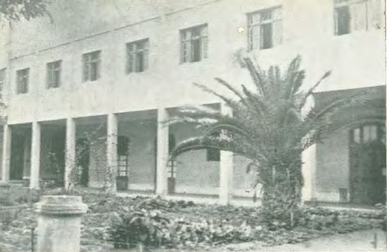
Pórticos del nuevo pabellón de edificio de la Casa de formación de Magdalena.
