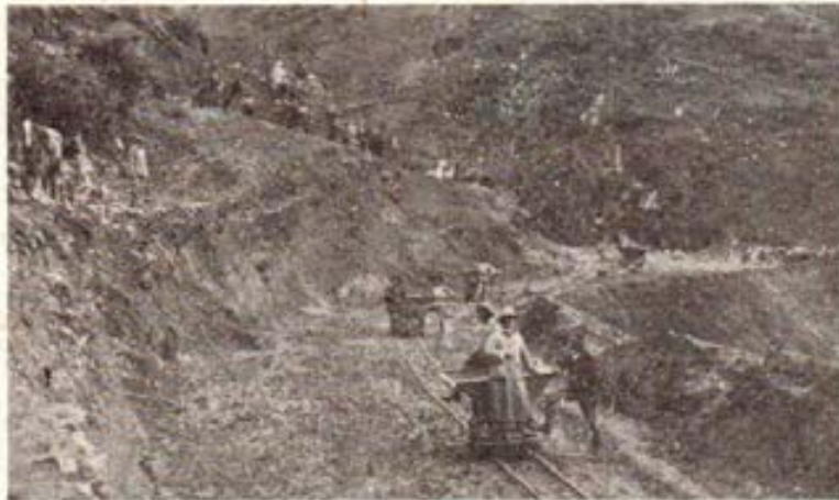
El Padre Francisco Paglia en los trabajos de la carretera a Sacsahuamán
