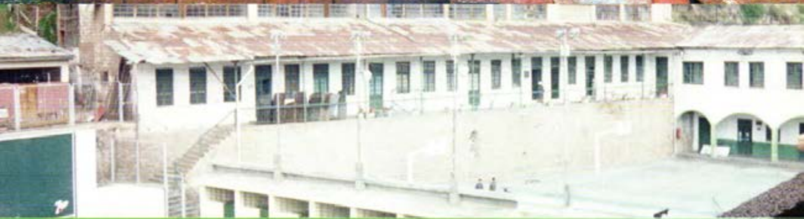
VISTA DEL LOCAL ANTIGUO Y ABAJO, PARTE DE LOCAL MODERNO
