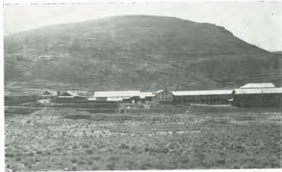
Vista general de la Granja.
