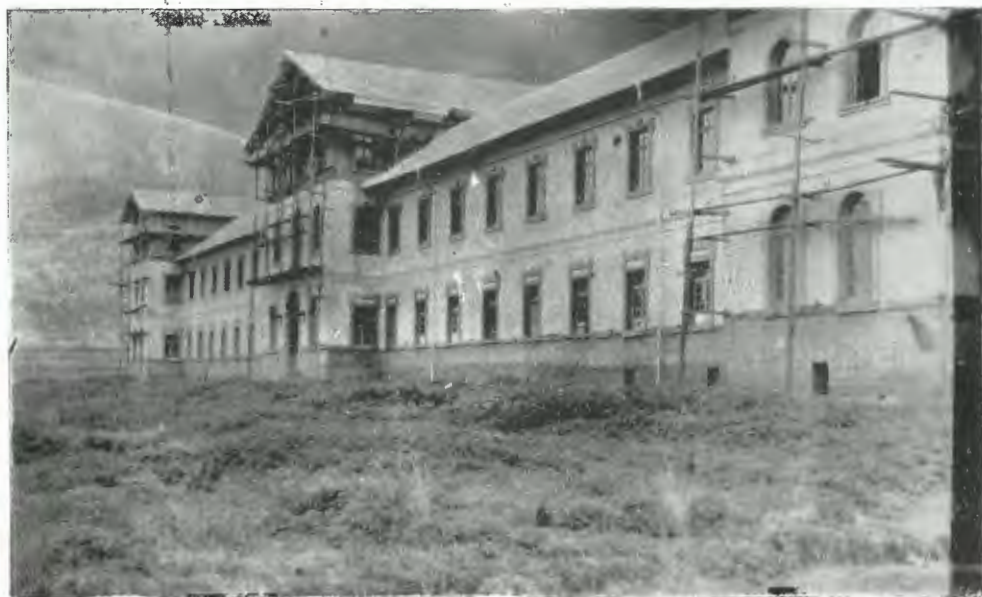
Fachada en construcción.
