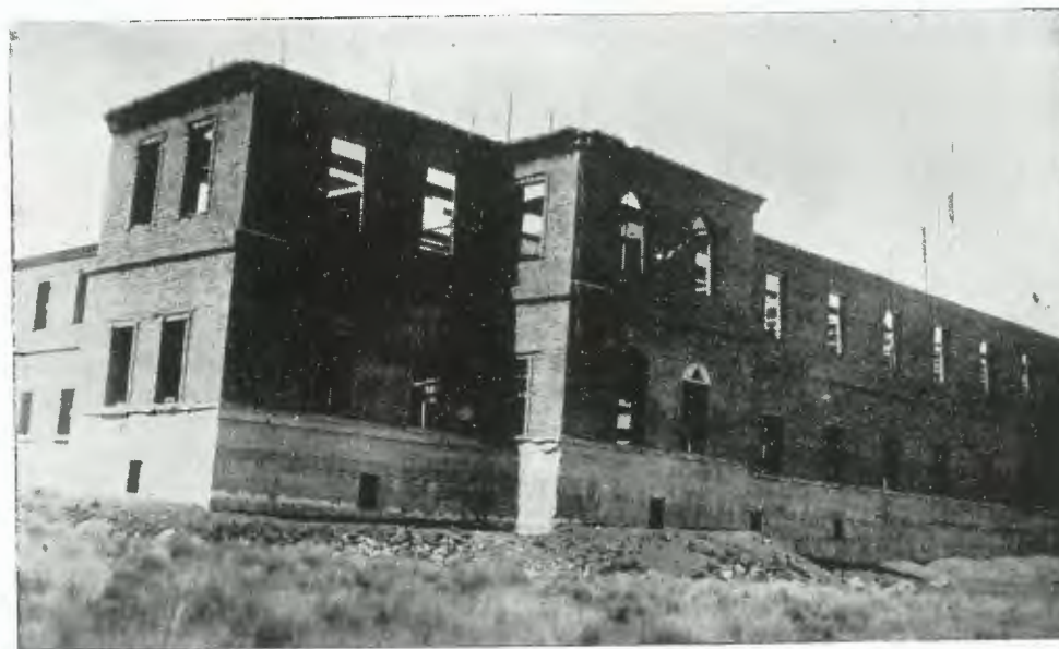
Otro aspecto de los trabajos a principios de julio de 1929.
