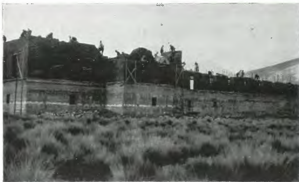
Estado de los trabajos a principios de marzo de 1929.
