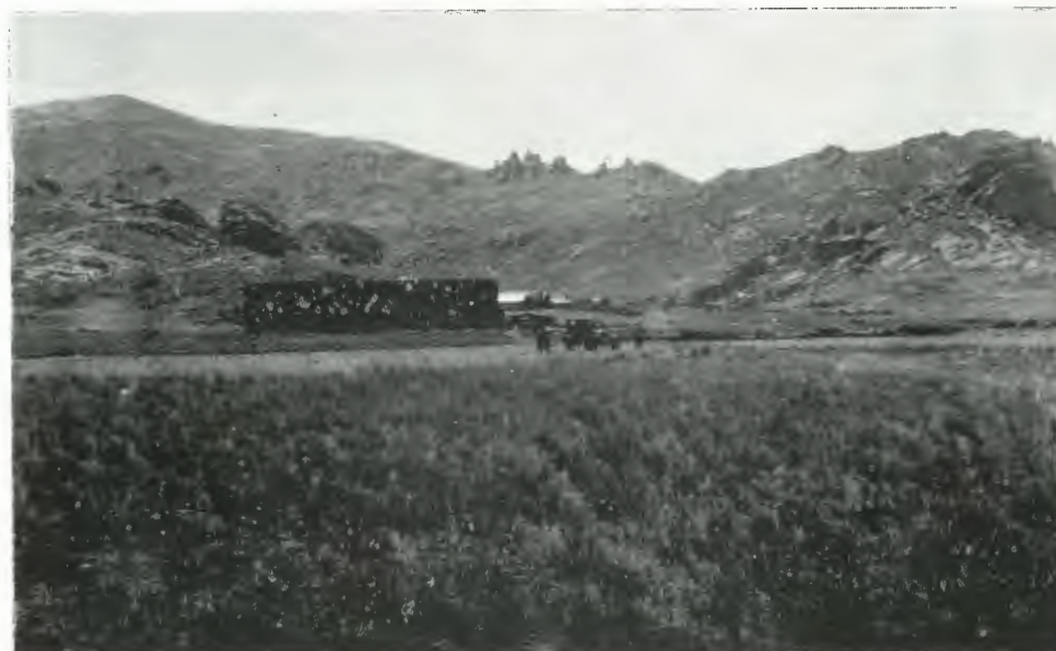
Vista panorámica de los trabajos en julio de 1929.
