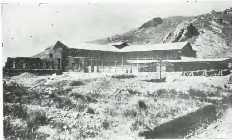
Primera parte del edificio inaugurado el 10 de agosto de 1929 con los primeros 120 alumnos.
