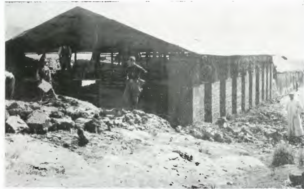
Construcción del establo para ganado vacuno.
