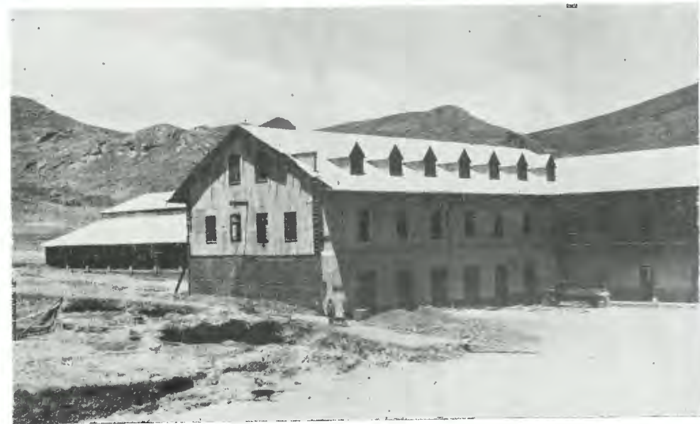
Suspección de los trabajos de construcción en agosto de 1930.
