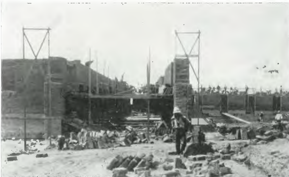
Estado de la construcción del edificio en mayo de 1929.
