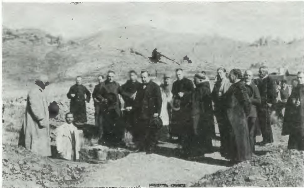
Colocación de la primera piedra. — 10 de Agosto, 1928.
