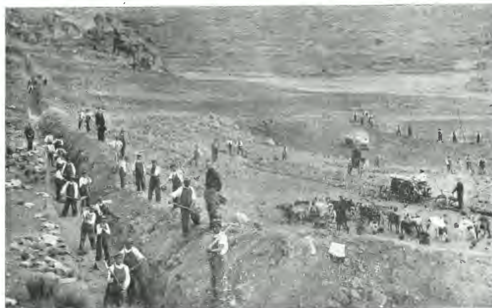
Trabajos de captación de aguas para defender las sementeras.
