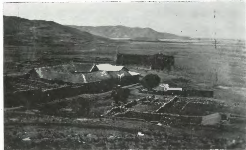
Antiguo caserío "Salcedo" y estado de los trabajos de construcción en abril de 1929.
