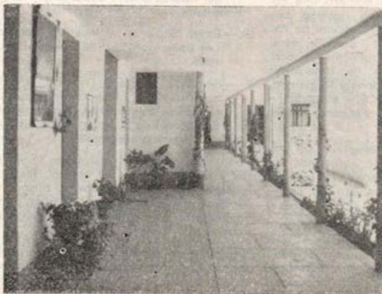
Hall de entrada de la casa solariega del Noviciado salesiano. Cochabamba.
